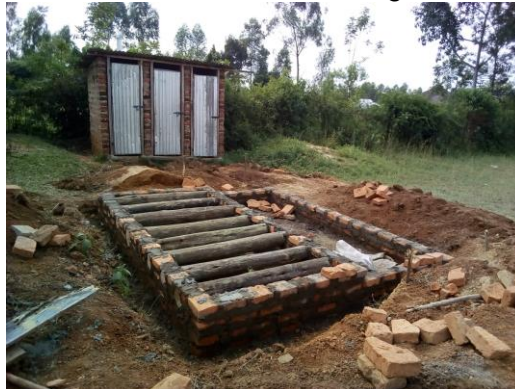
De septic tank is ingegraven. Achterin de oude wc's
