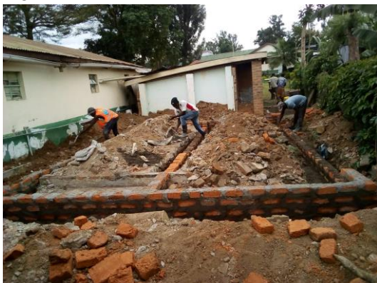
Maken van het fundament.
