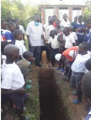
Het gat voor de septic tank
