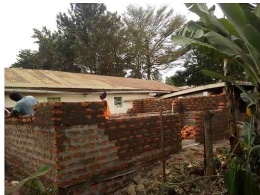
Opbouwen van de muren met de bricks
